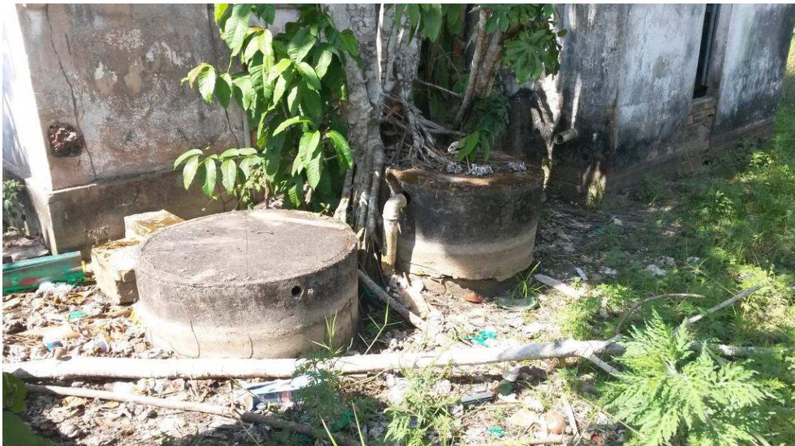
Foto 7 – Antiga ETE da edificação, sem condições de reaproveitamento.
