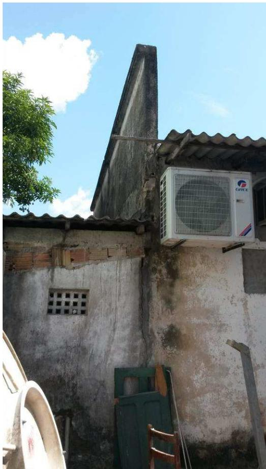
Foto 10 – Fundos do prédio apresentam rachaduras e também se observa as péssimas condições das instalações dos condicionadores de ar.
