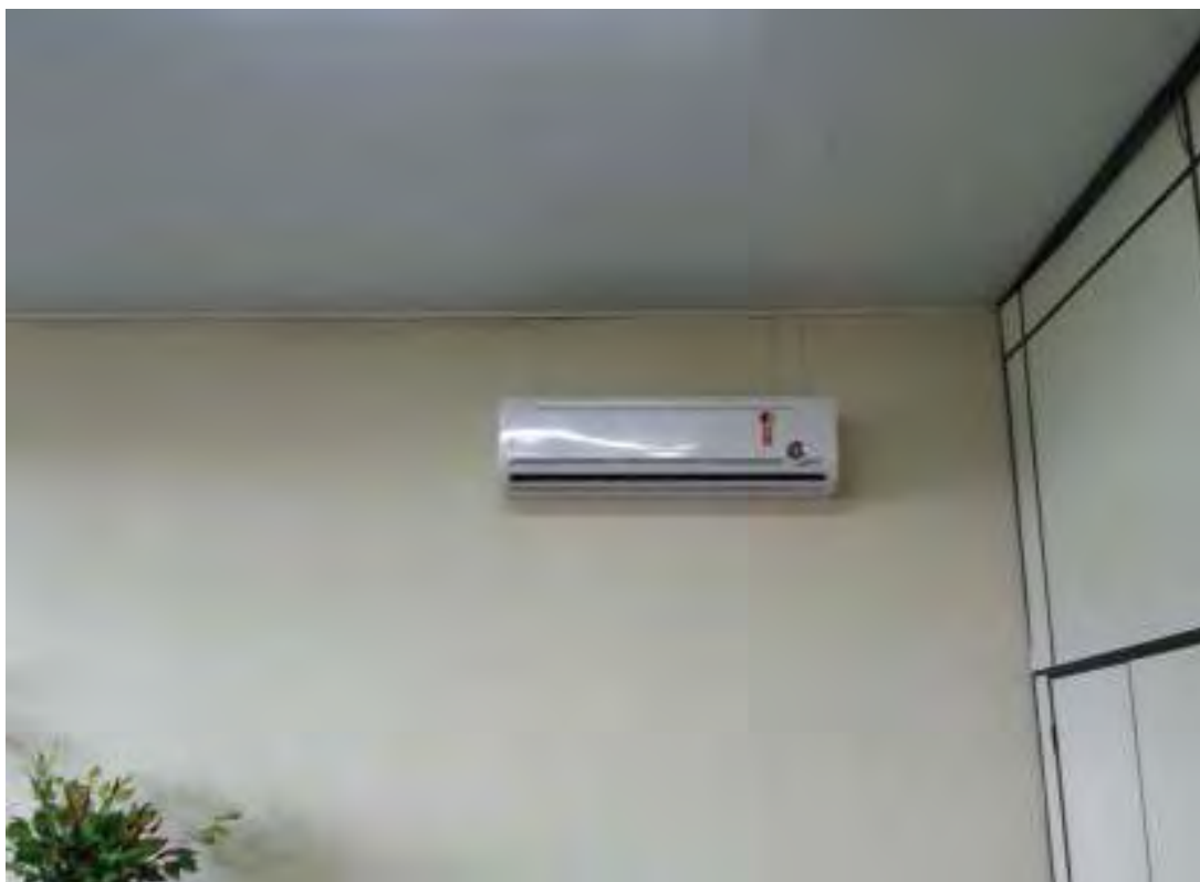
Figura 11 : Falta de pintura
