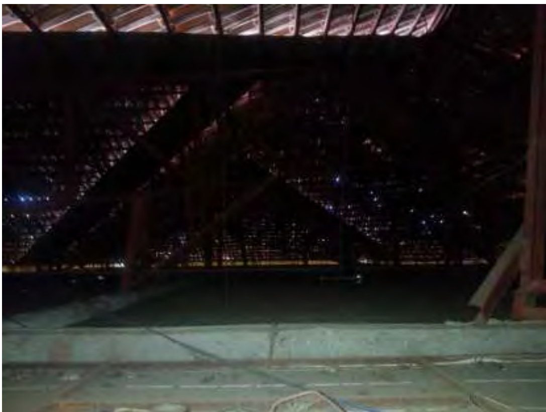
Figura 05: Telhas espaçadas.
