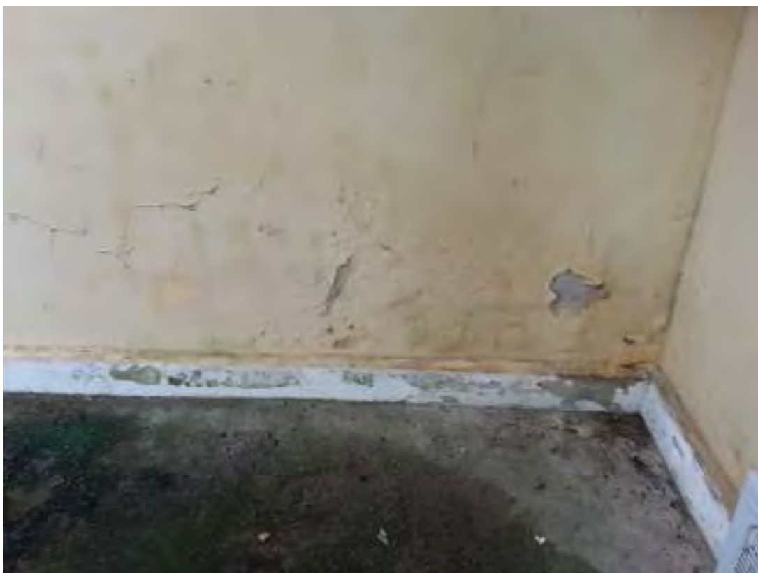
Figura 03: Infiltração.
