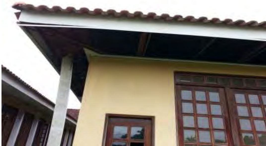
Figura 01 : Beiral sem forro
