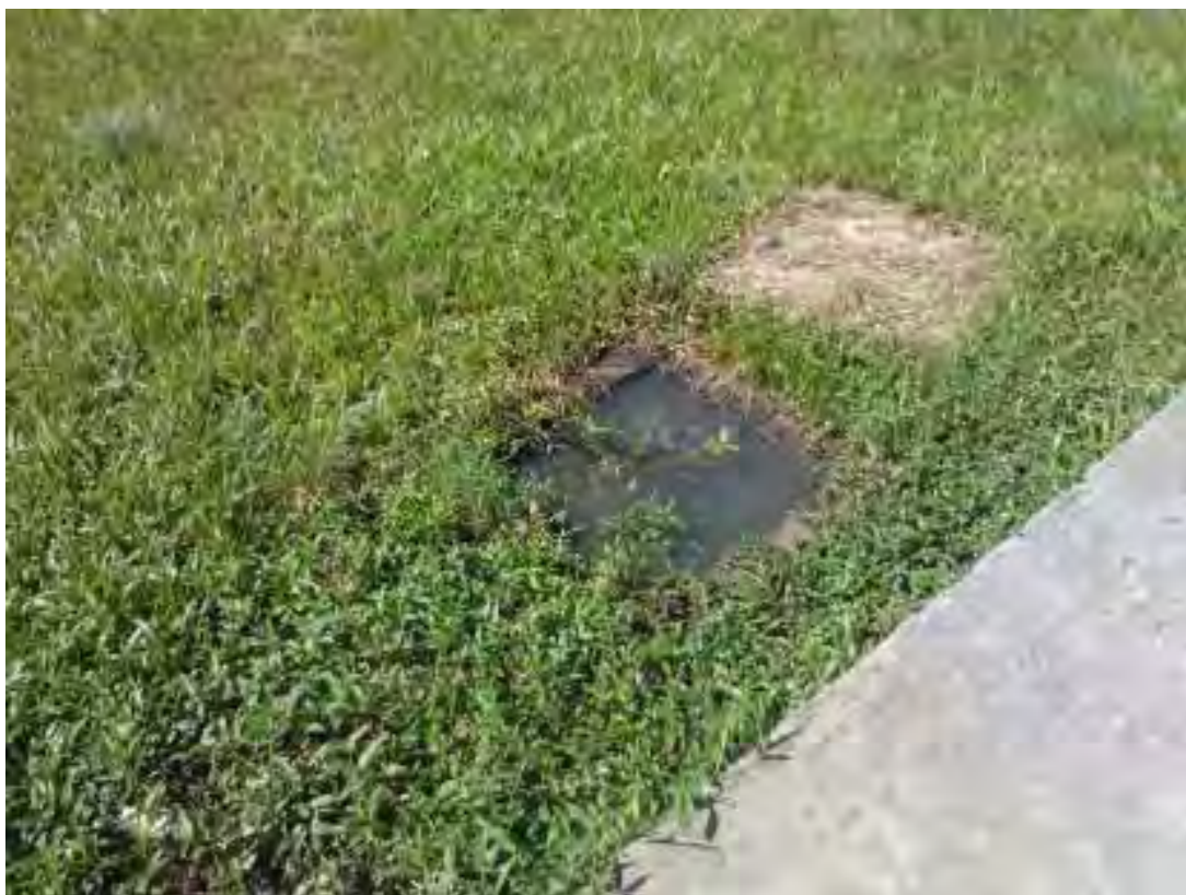
Figura 09: Caixa entupida.
