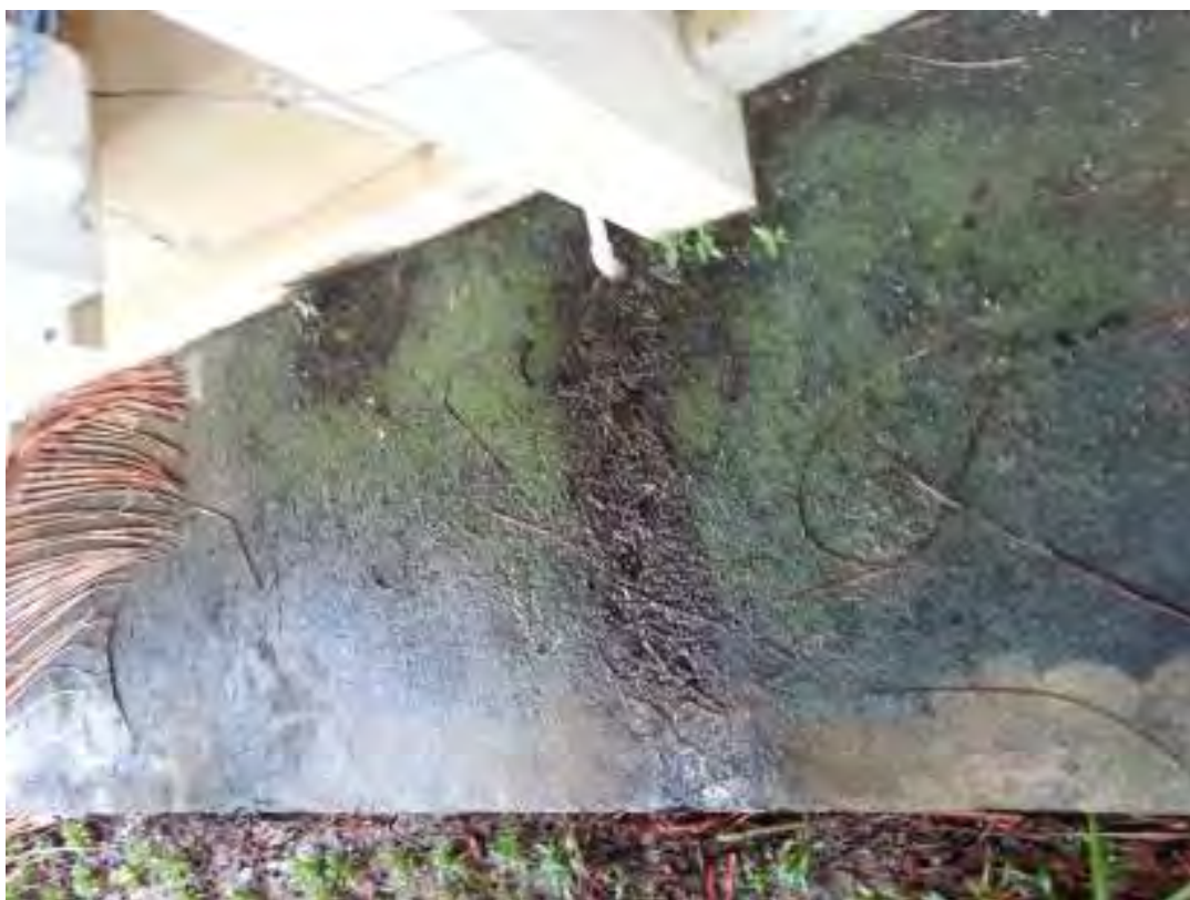
Figura 03: Infiltração.
