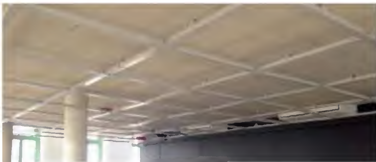
Módulos com 1100 mm de comprimento fixos através de talas laterais. Reduz o tempo de instalação, mantendo a obra limpa e evitando o tradicional quebra-quebra.
