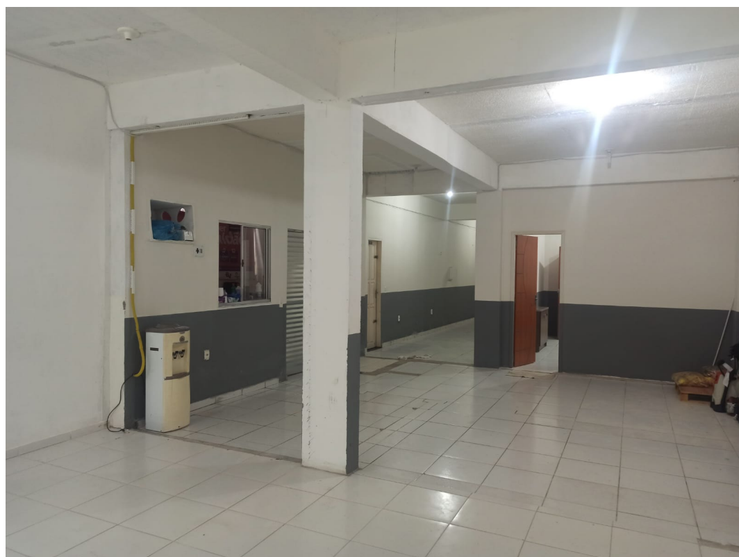
Figura 5 – Interior do depósito
