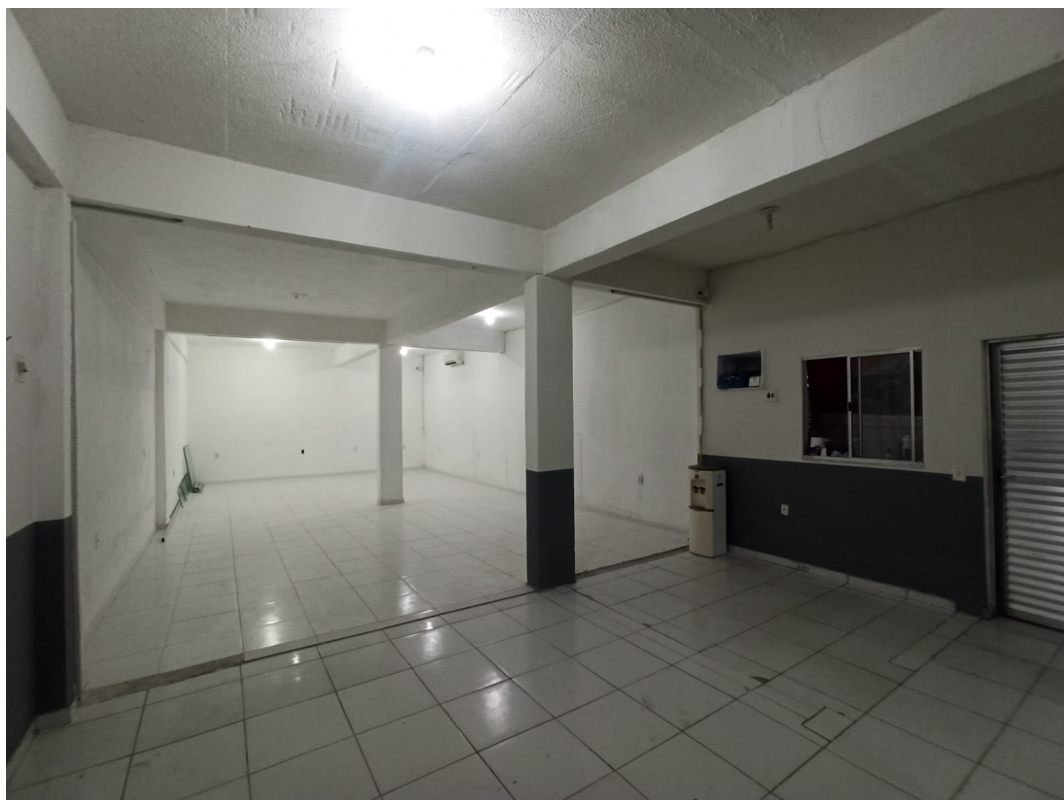
Figura 4 – Interior do depósito
