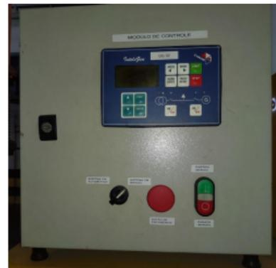
FIGURA 2 - Disjuntor de 1600A e Controlador do gerador
