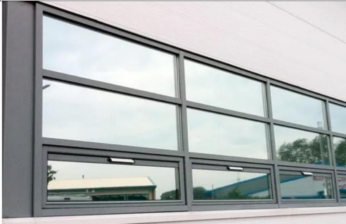
Acabamento em janelas de vidro
