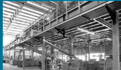
Mezanino ou passarela
