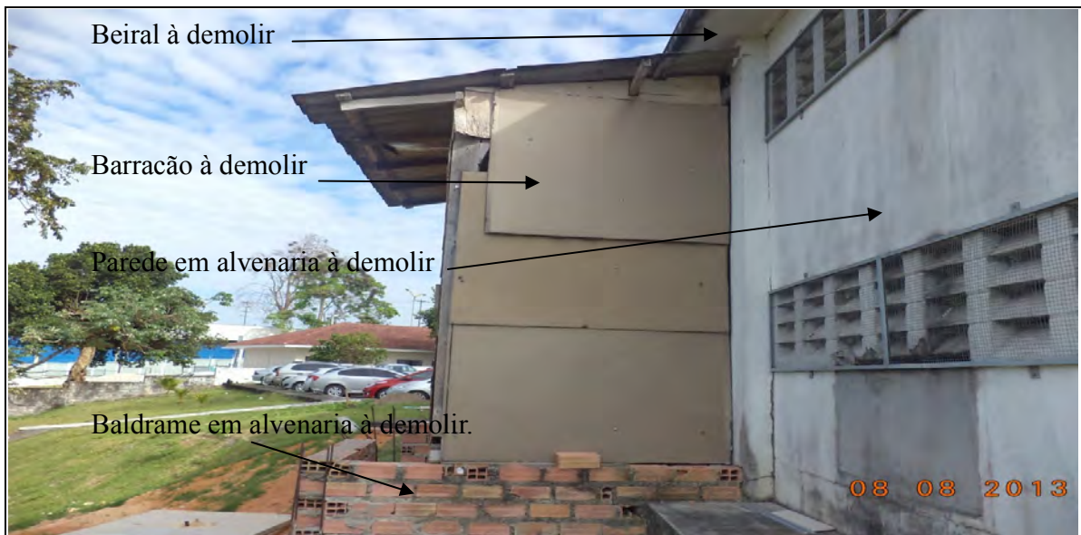
Figura 03: Vista da estrutura existente – demolir
