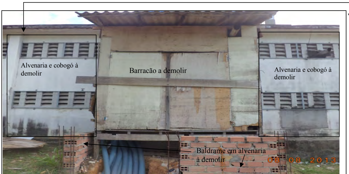
Figura 04: Vista dos Fundos – estrutura existente – demolir e construir
