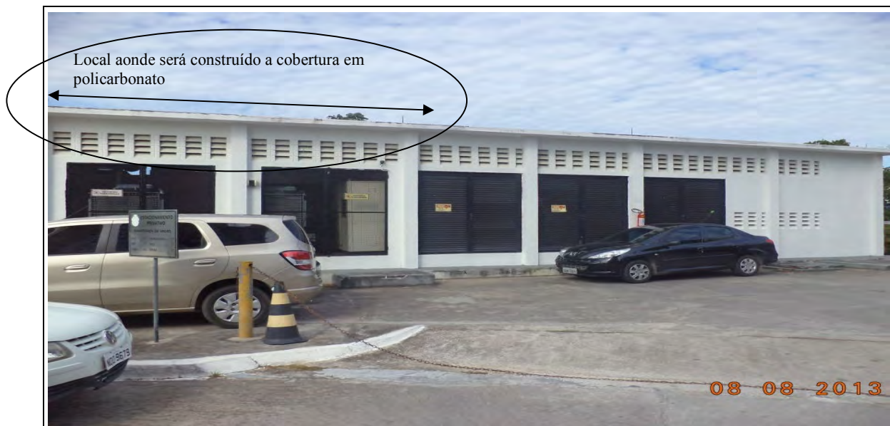
Figura 01: Vista Frontal da Subestação – construir cobertura em policarbonato.
