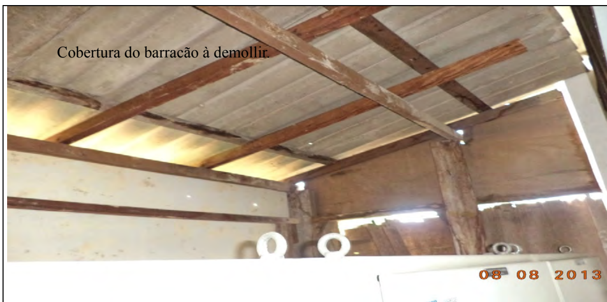
Figura 06: Vista da estrutura interna existente – demolir
