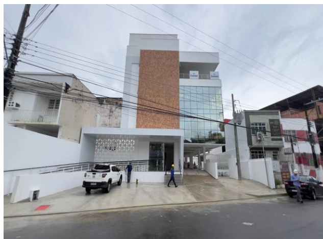
FOTO- 02 : FACHADA DO PREDIO FINALIZADA
