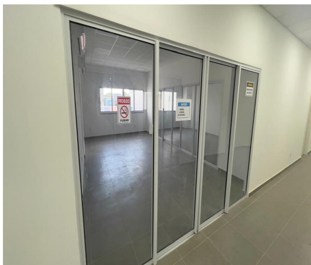
FOTO- 03 : ESQUADRIAS INSTALADAS
