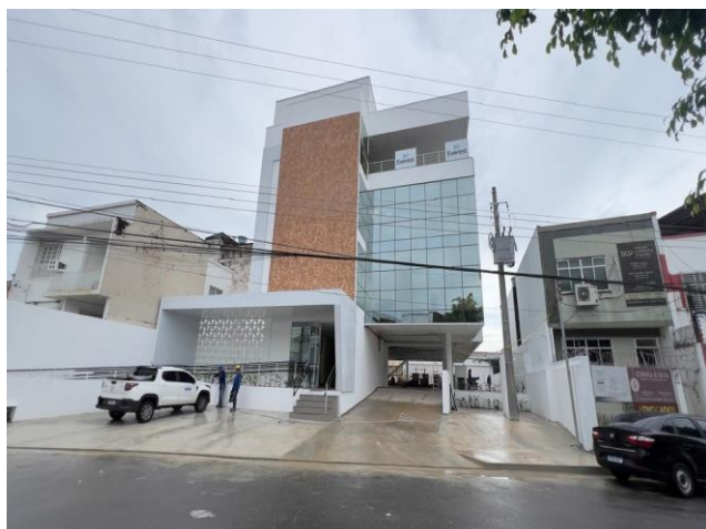
FOTO- 01 : FACHADA DO PREDIO FINALIZADA
