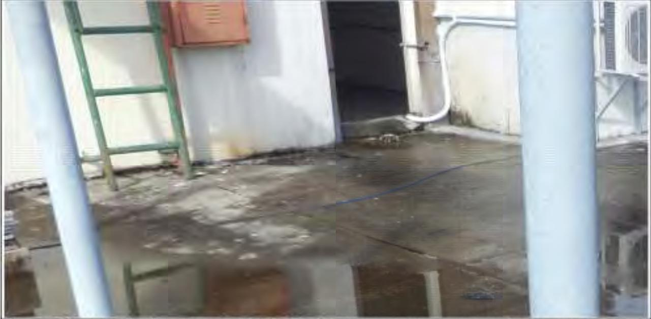
Figura 02: Laje da Cobertura do Prédio Sede do Tribunal de Justiça do Amazonas com Fissuras e Acúmulo de água
