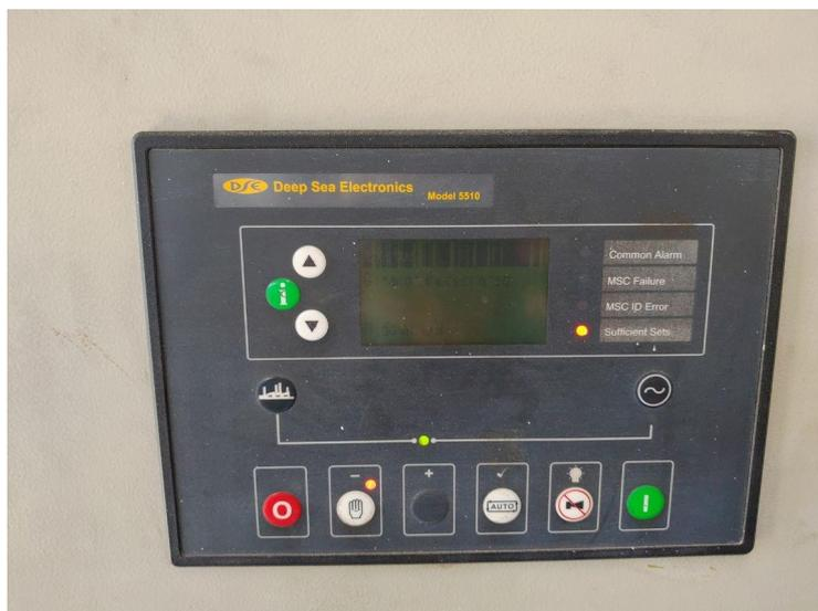
Figura 1 – Controlador DSE5510 com falha de leitura no barramento e display defeituoso.
