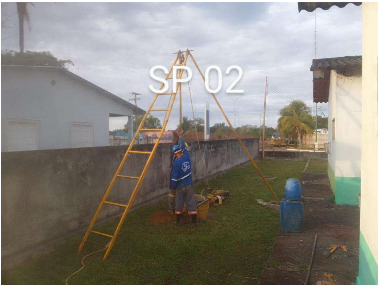
Foto 02 – Execução da Sondagem
