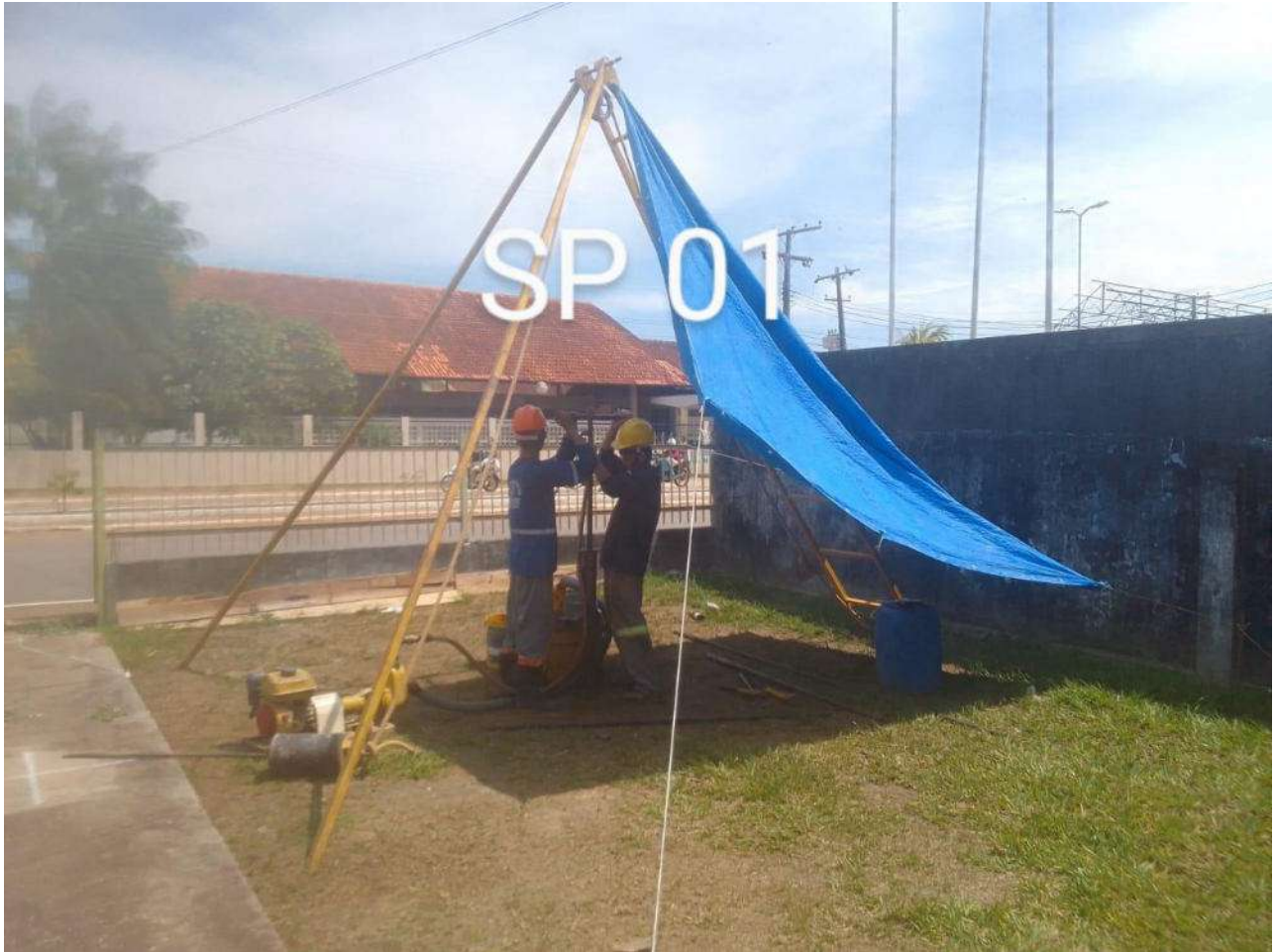
Foto 01 – Execução da Sondagem
