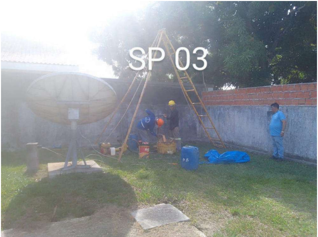
Foto 03 – Execução da Sondagem
