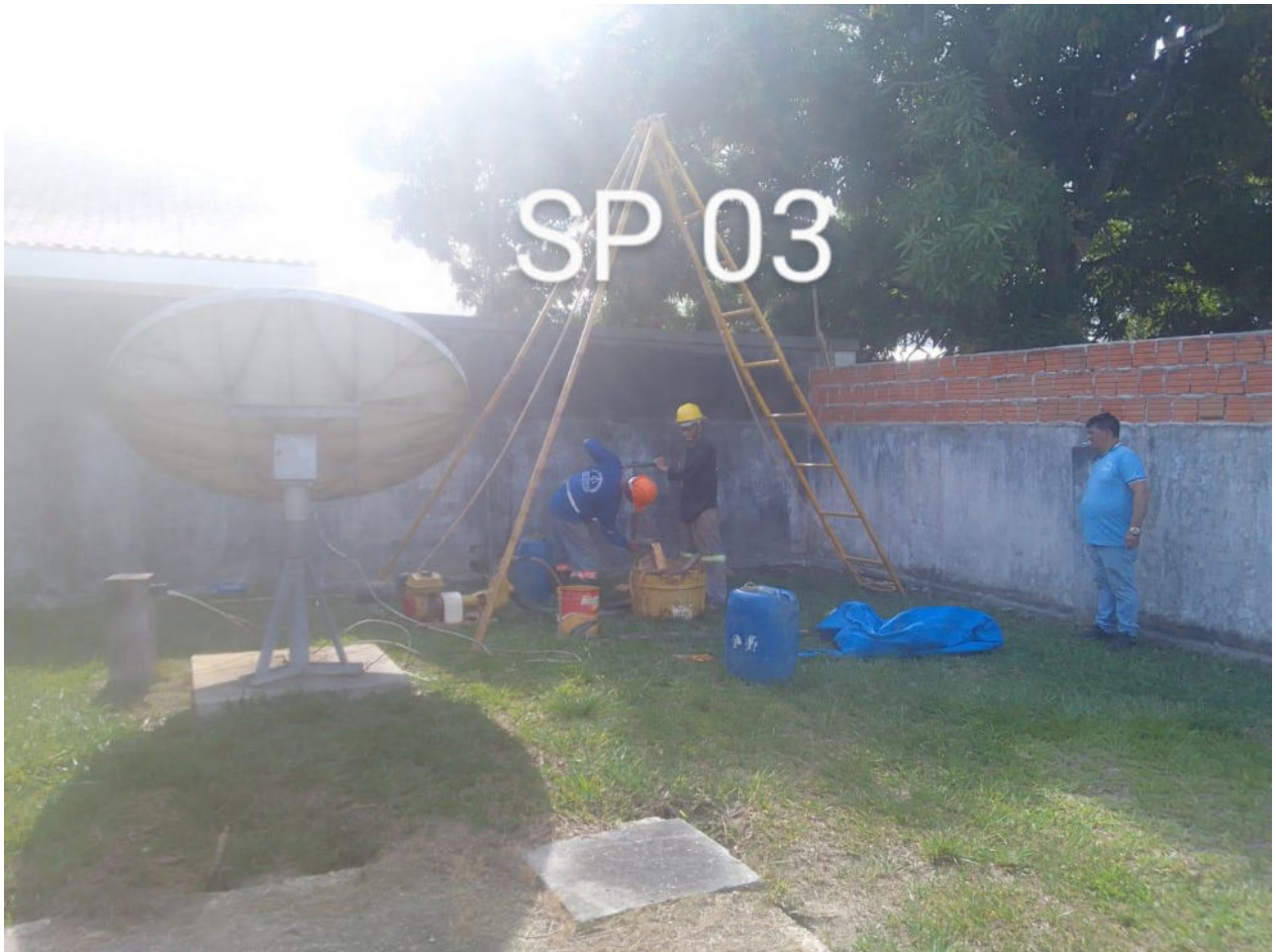
Foto 03 – Execução da Sondagem
