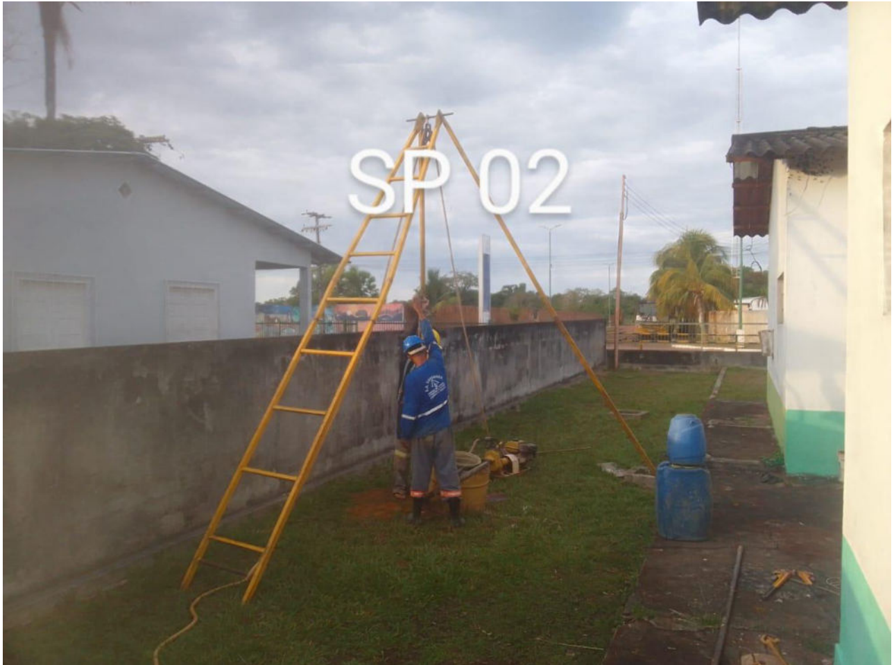
Foto 02 – Execução da Sondagem
