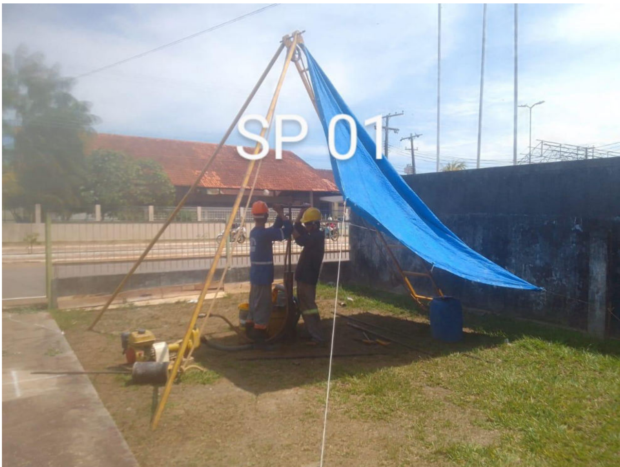
Foto 01 – Execução da Sondagem
