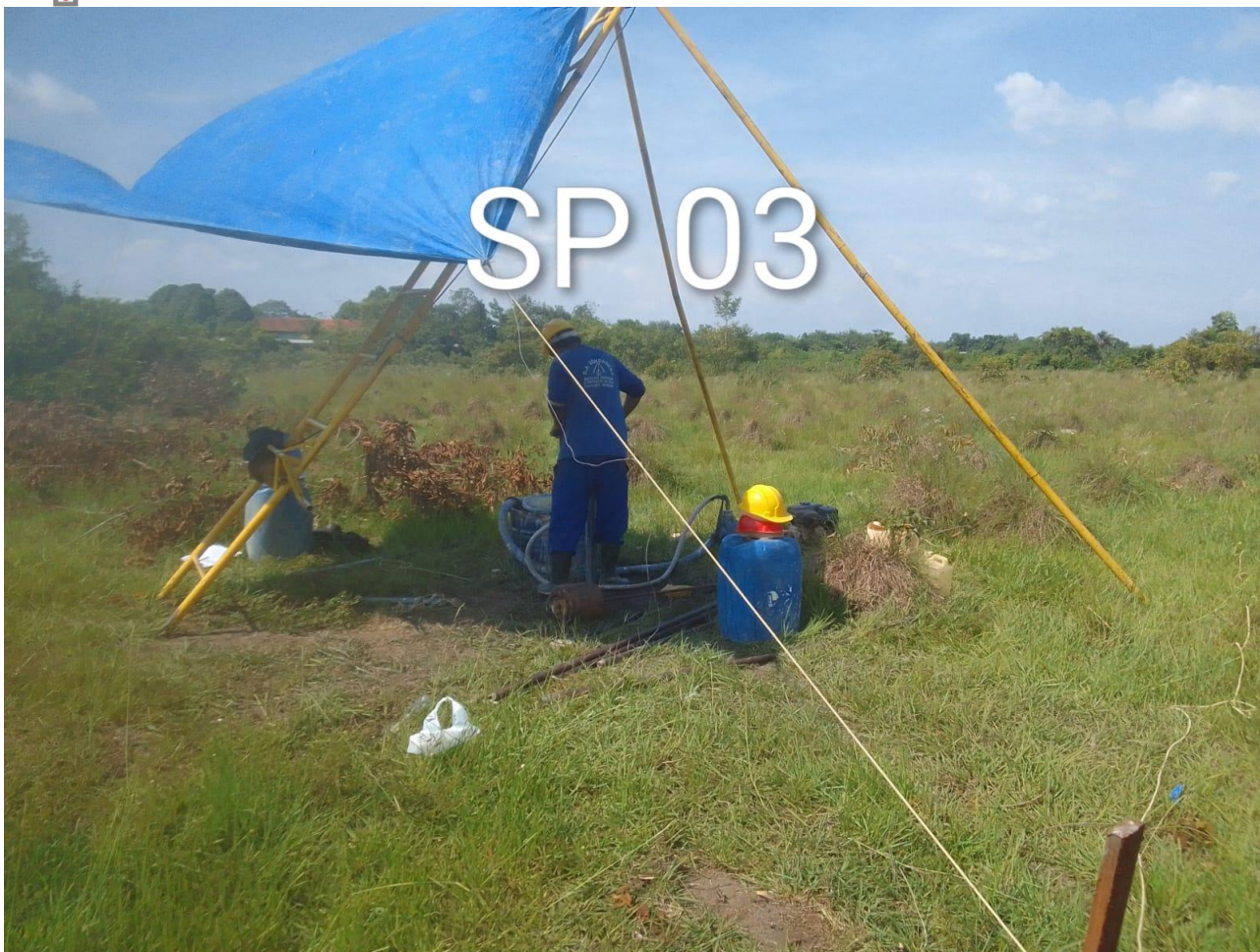
FOTO 04: Execução do SP-03
