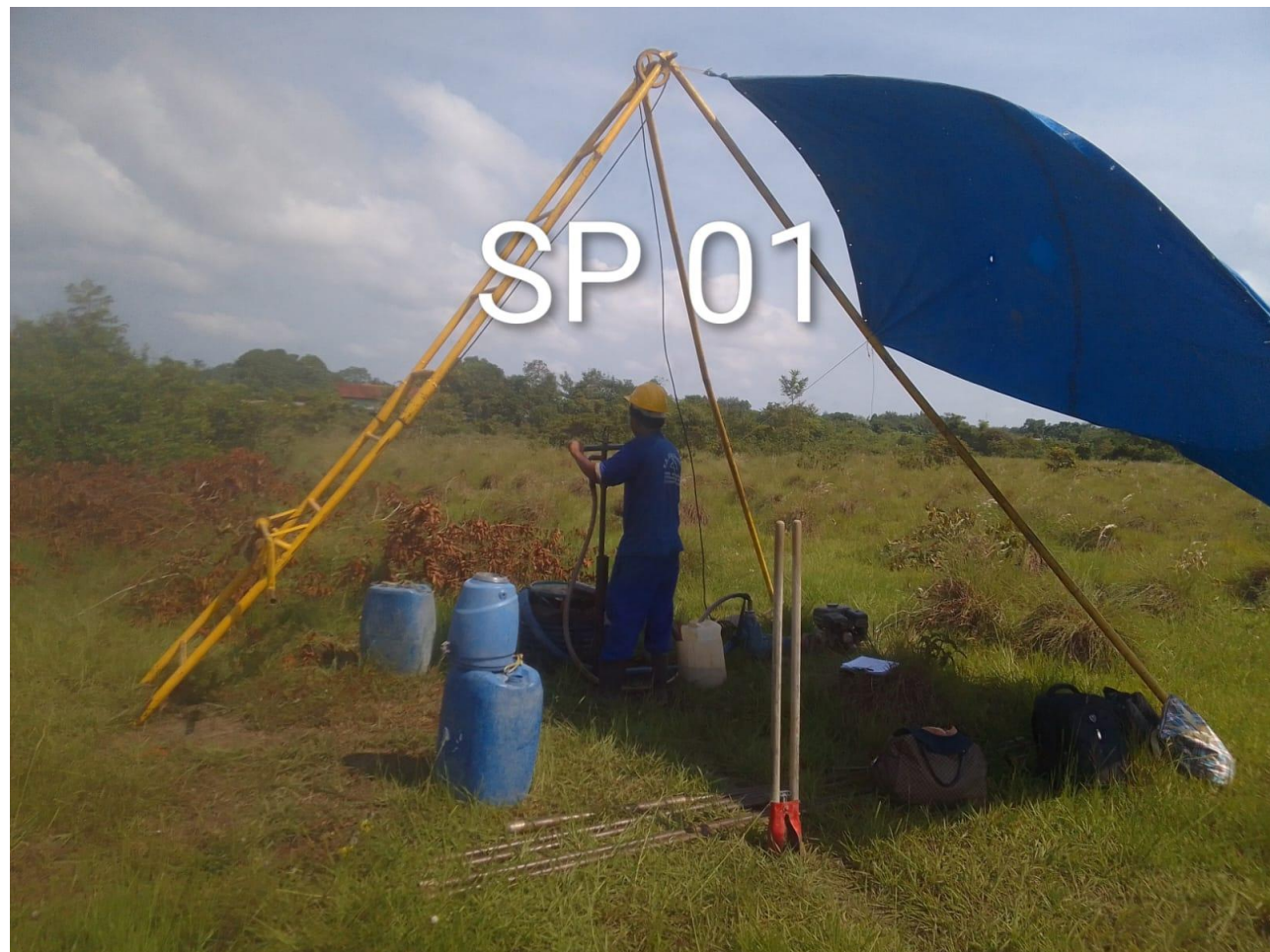
FOTO 01: Execução do SP-01
