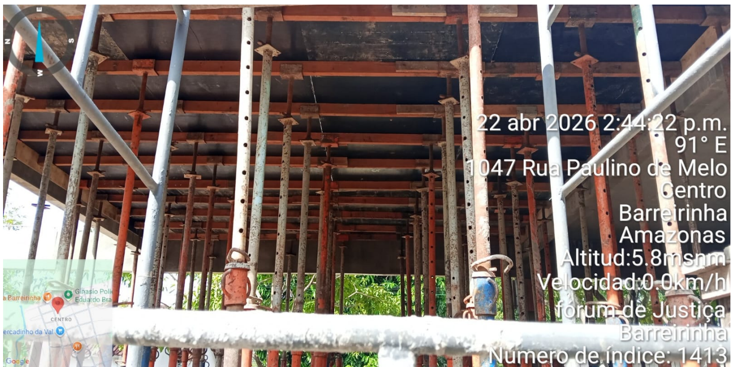
7. Acompanhamento de obra do novo Fórum de Carreio da Várzea, durante o mês de abril de 2026
