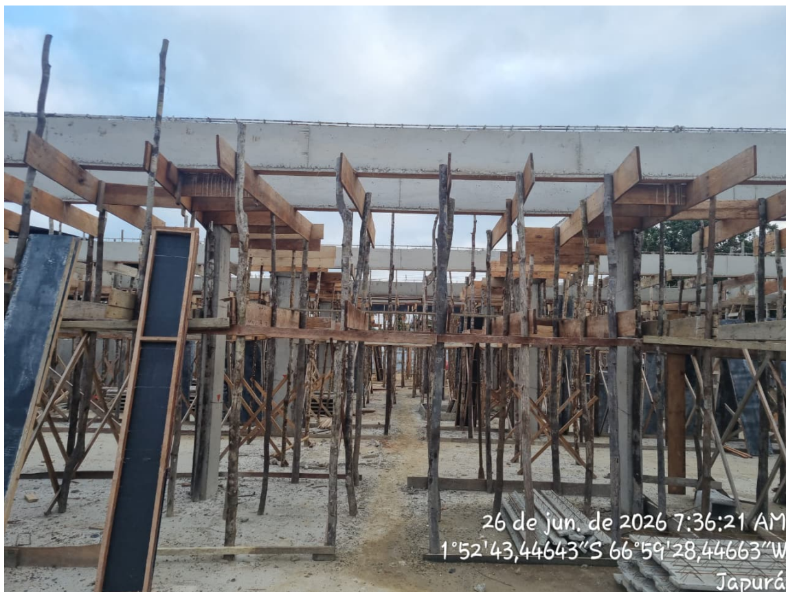
5. Acompanhamento de obra do novo Fórum de Lábrea, durante o mês de junho de 2026
