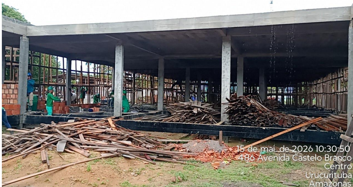
9. Acompanhamento de obra do novo Fórum de Boca do Acre , durante o mês de maio de 2026
