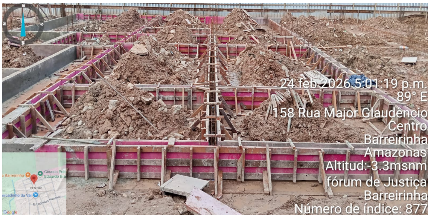
7. Acompanhamento de obra do novo Fórum de Careiro da Várzea, durante o mês de fevereiro de 2026
