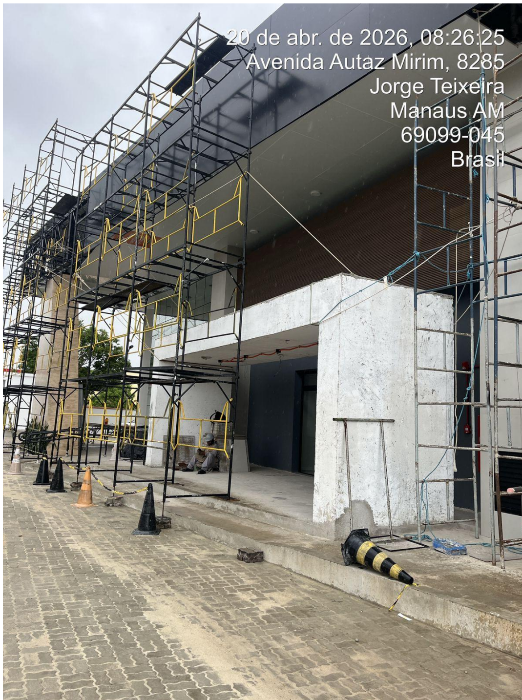
4. Acompanhamento de obra do novo Fórum de Japurá , durante o mês de abril de 2026
