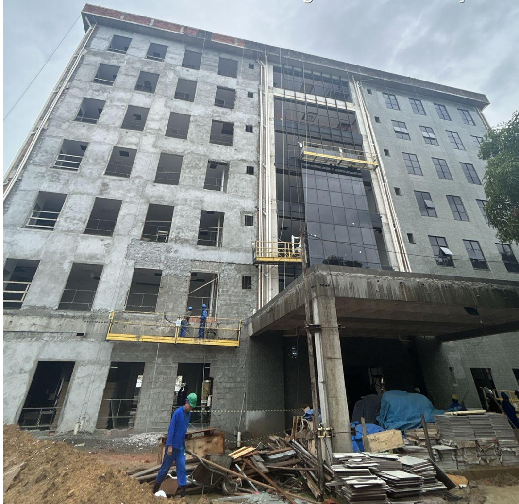
3. Acompanhamento de obra do Fórum Azarias de Vasconcelos, durante o mês de fevereiro de 2026
