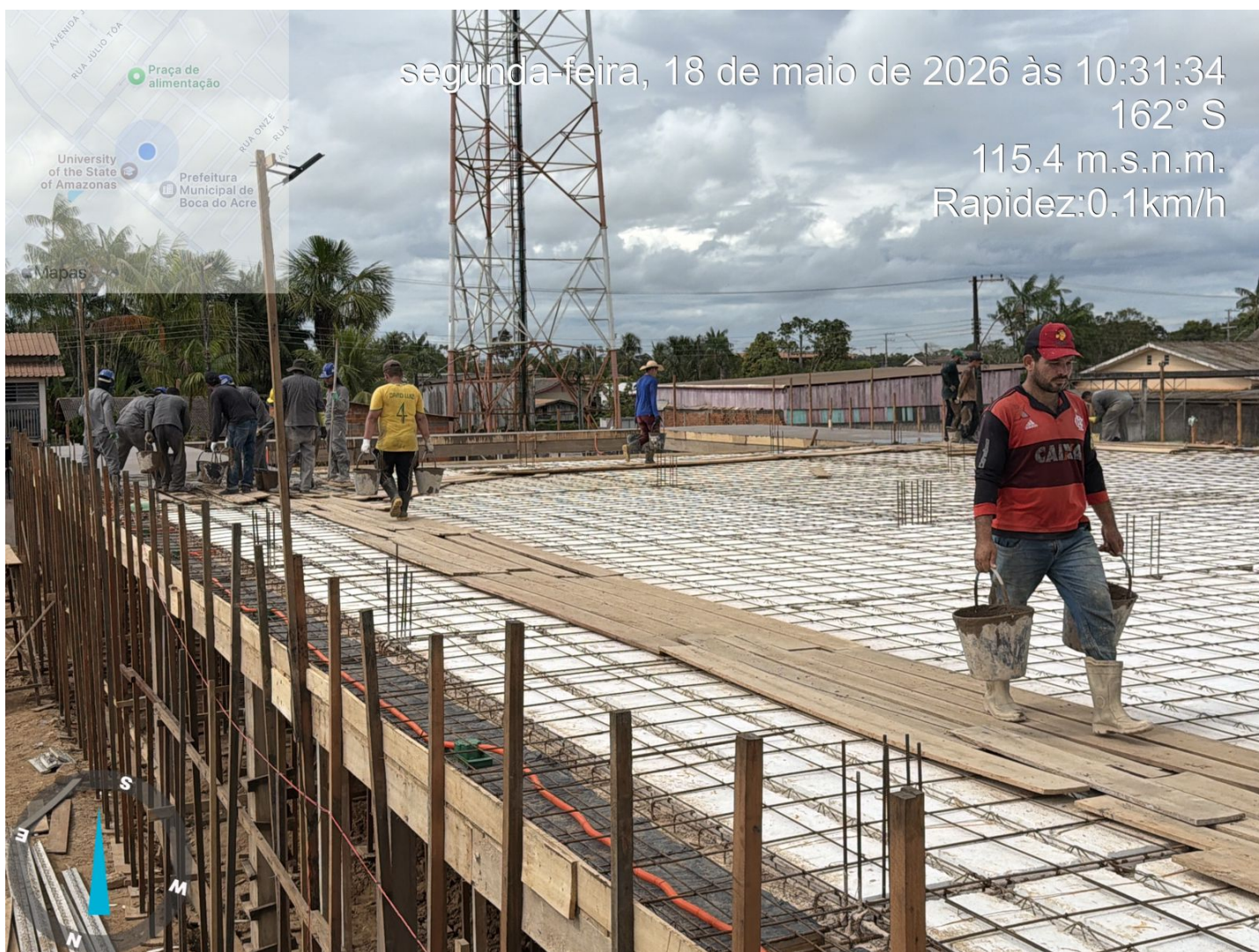
10. Acompanhamento de obra do novo Fórum de São Gabriel da Cachoeira , durante o mês de maio de 2026
