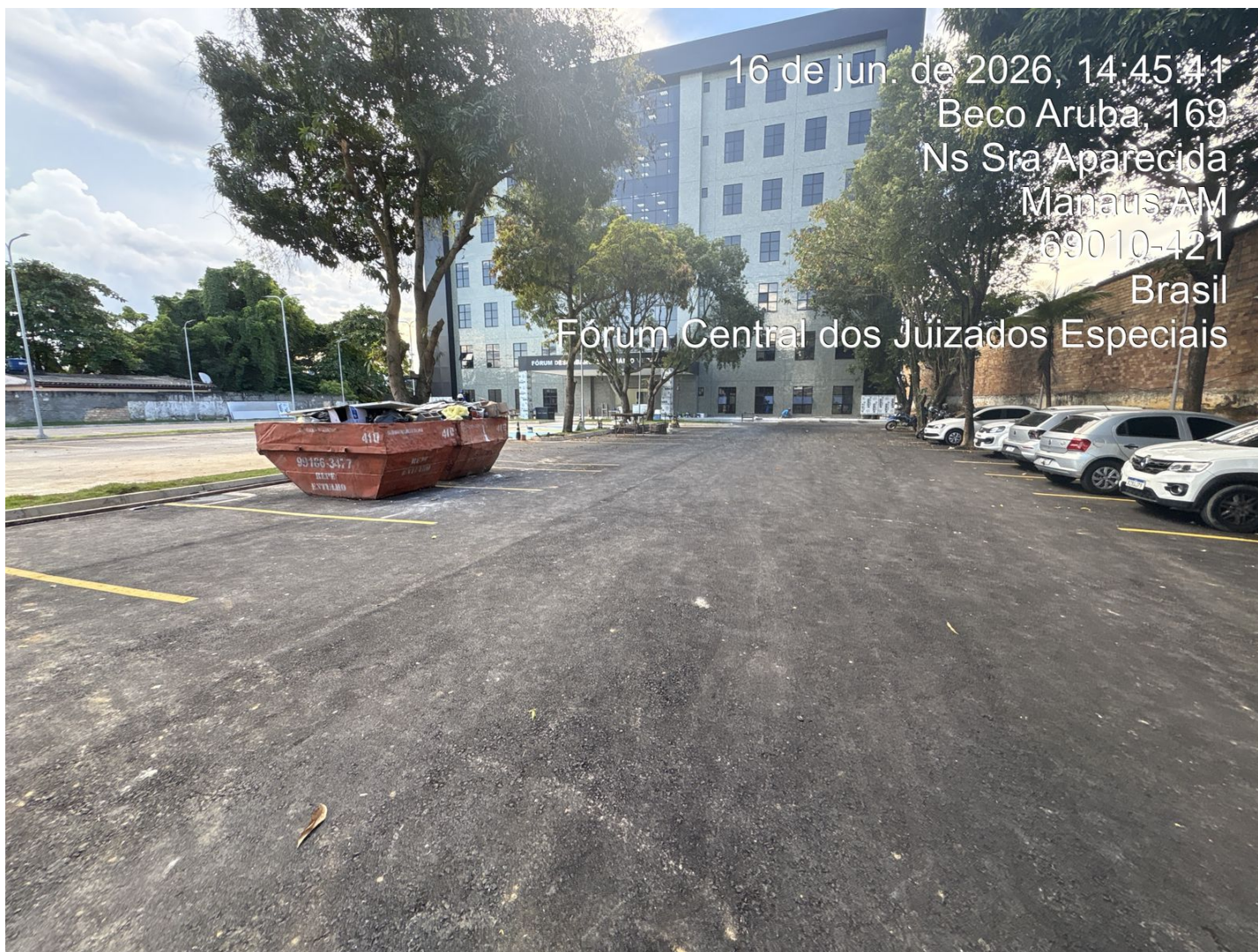
3. Acompanhamento de obra do novo Fórum de Coari, durante o mês de junho de 2026
