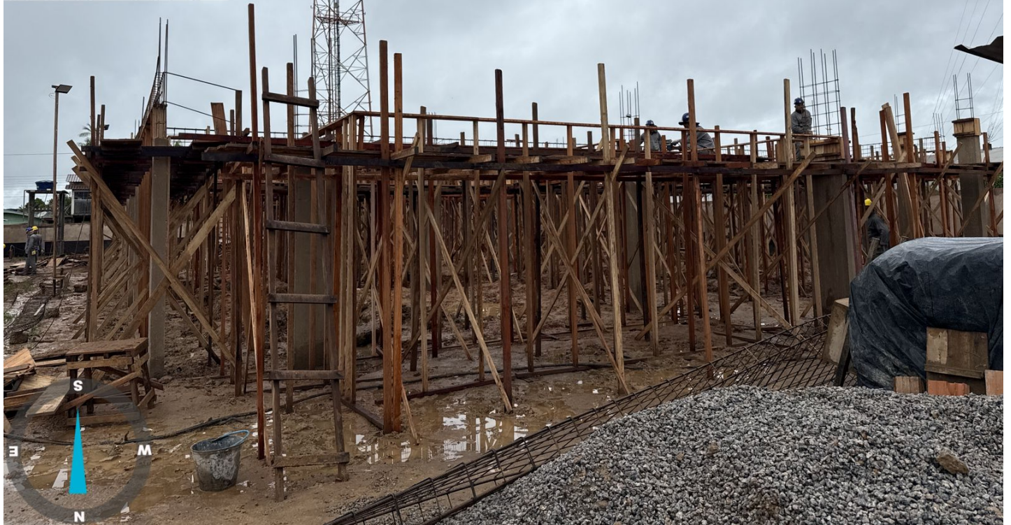
10. Acompanhamento de obra do novo Fórum de São Gabriel da Cachoeira , durante o mês de abril de 2026
