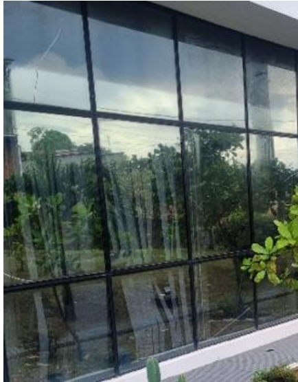
FOTO DA FACHADA EXISTENTE
