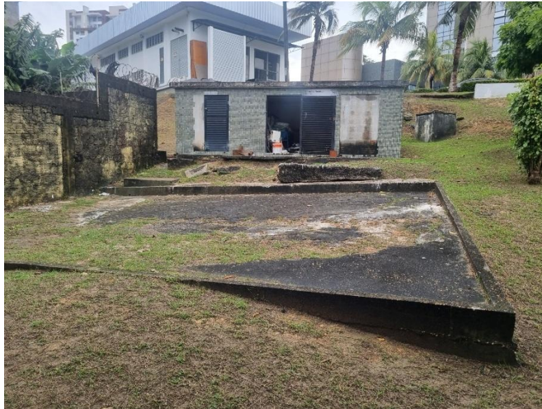
FOTO DA BASE DE CONCRETO (GMG E CONDENSADORAS)
