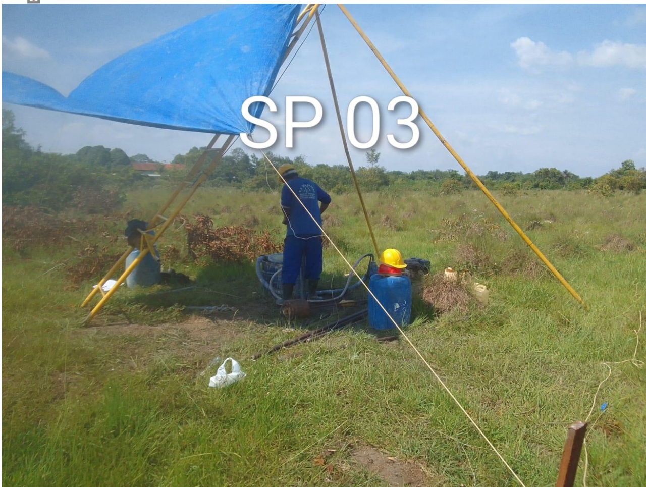
FOTO 04: Execução do SP-03
