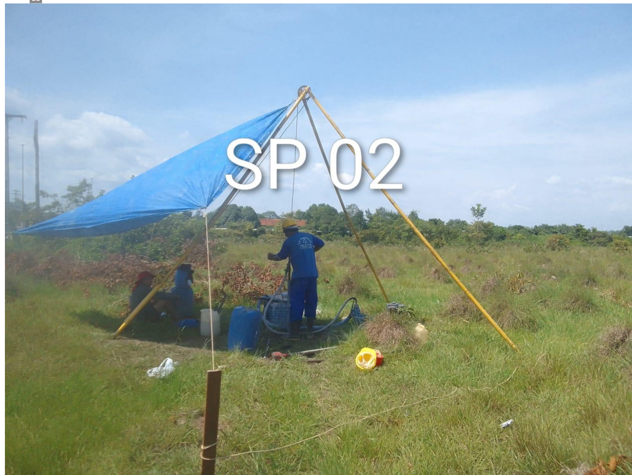
FOTO 02: Execução do SP-02
