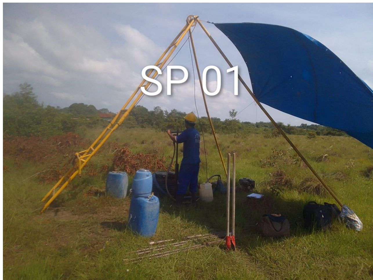
FOTO 01: Execução do SP-01
