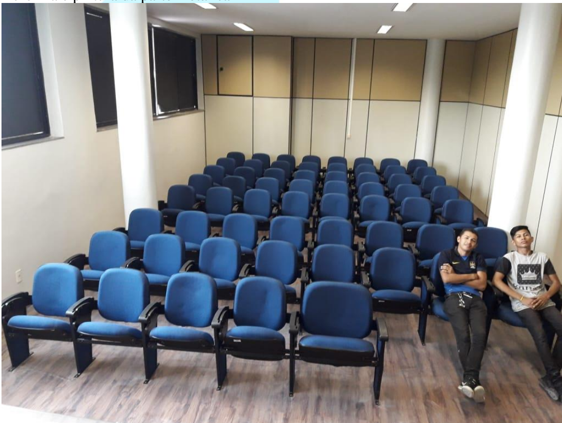
Reforma e pintura da parte metálica
