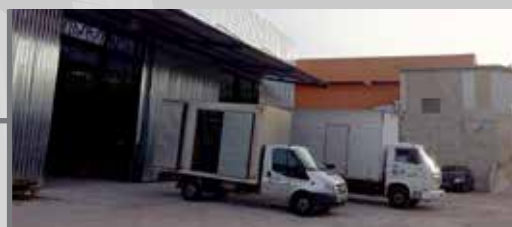
Centro de Distribuição - Socorro/SP
