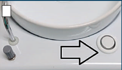
Acionamento temporizador de água por botão
