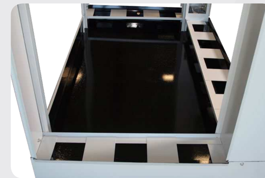
Aplicação de tinta anticorrosiva em base de equipamento
