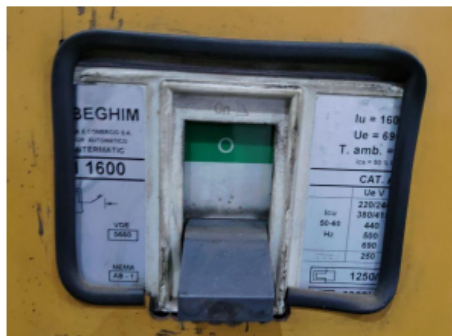
FIGURA 2 - Disjuntor de 1600A e Controlador do gerador
