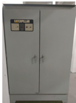
FIGURA 3 - Quadro de Transferência Automática
