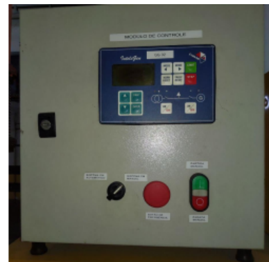
FIGURA 2 - Disjuntor de 1600A e Controlador do gerador
