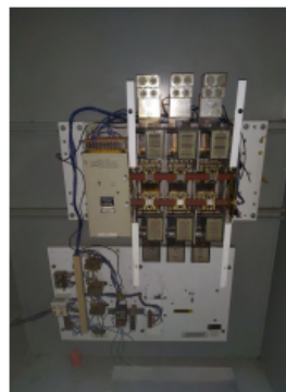
FIGURA 3 - Quadro de Transferência Automática
