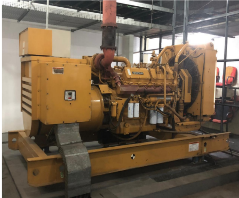
FIGURA 1 - Foto situacional do grupo gerador
